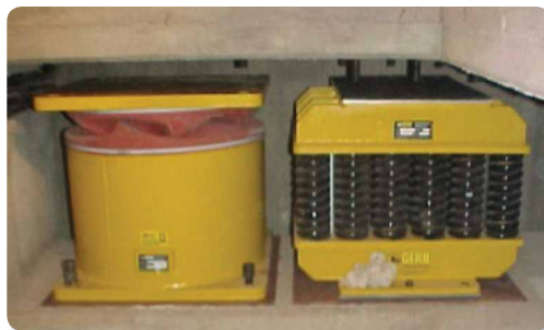
c) Aislador de resortes y su correspondiente amortiguador viscoso.
