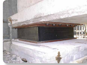
a) Aislador de goma reforzada con núcleo de plomo.
