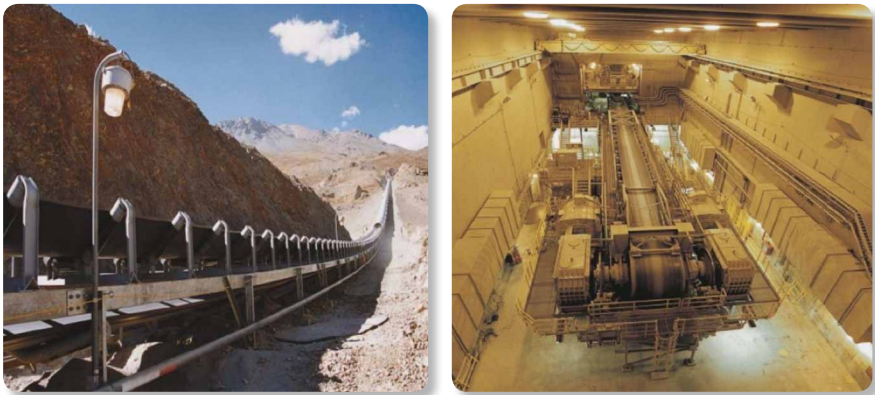
Figura 1: Correa transportadora de Minera Los Pelambres (Ref: Siemens AG).
